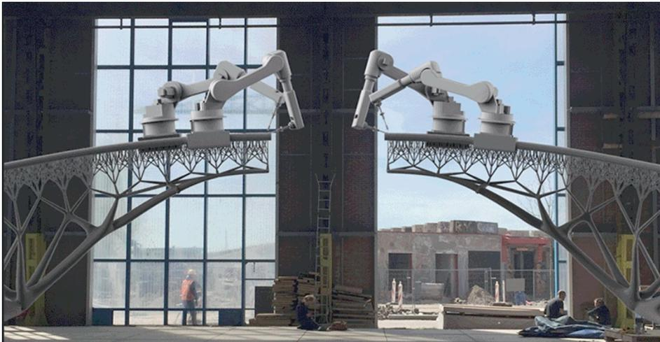
Abbildung 13.5: 3D-gedruckte Brücke (Foto: MX3D)
